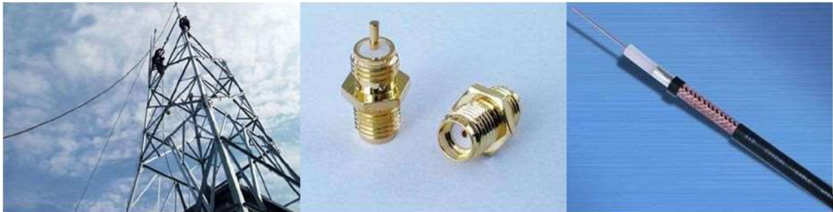
1. 通信基站维护
